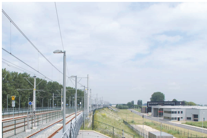
12. RandstadRail, en halte voorbereid
