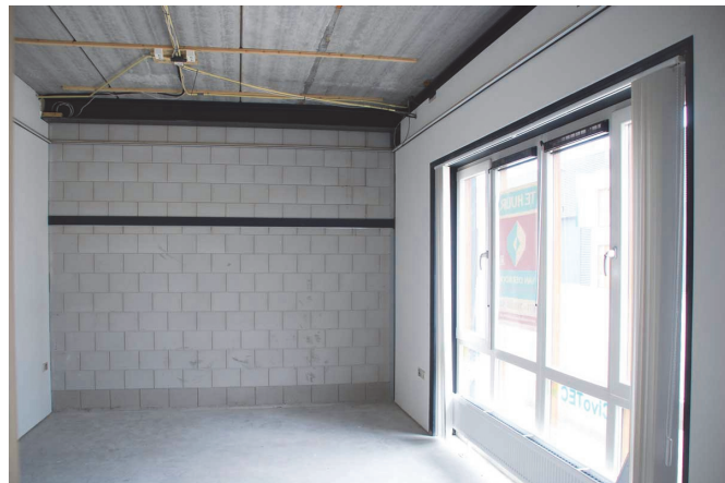
6. Kantoor/showroom begane grond
